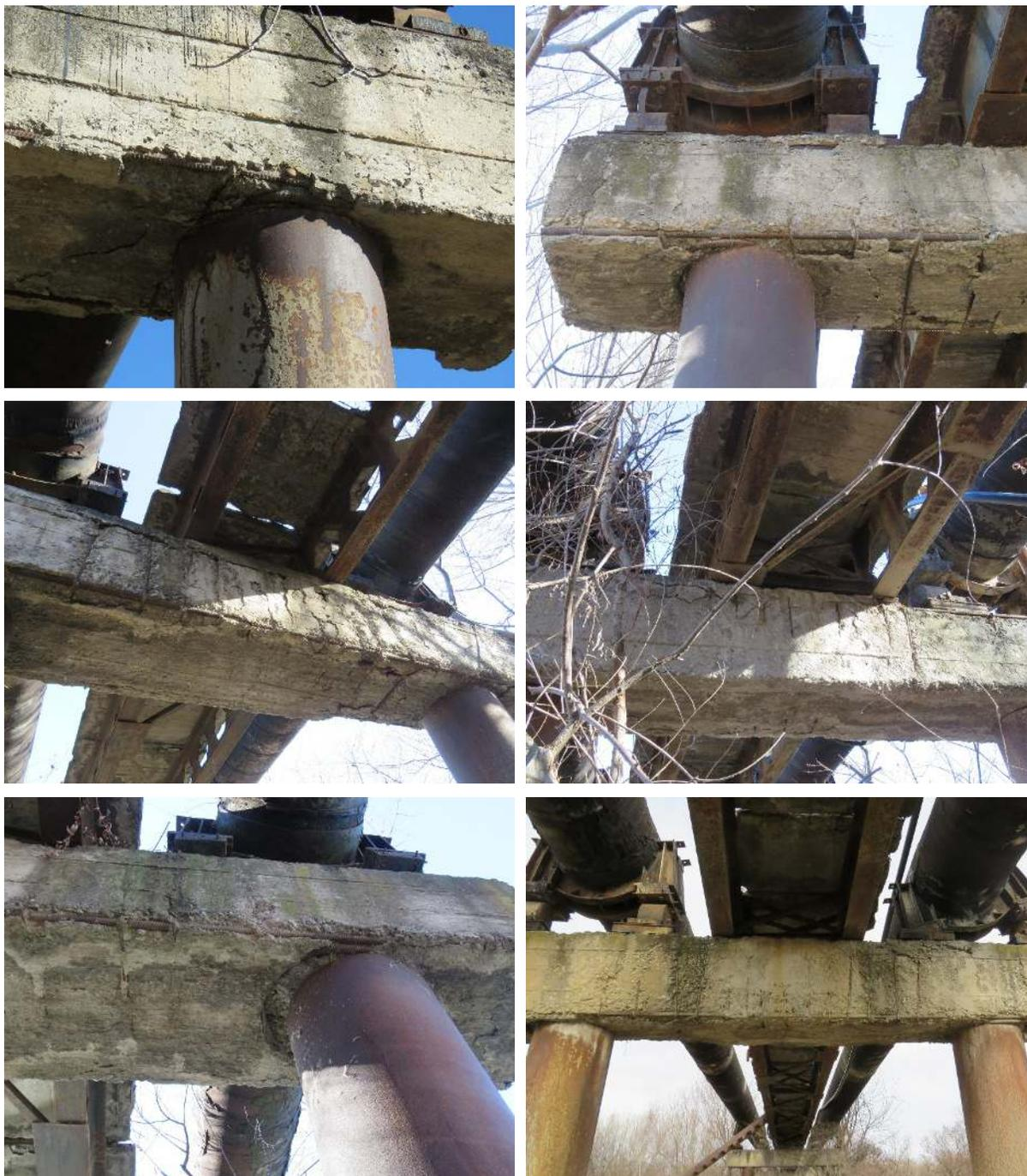
სურ. 1. რკინაბეტონის რიგელის დაზიანებული დამცავი ფენის ბეტონი
