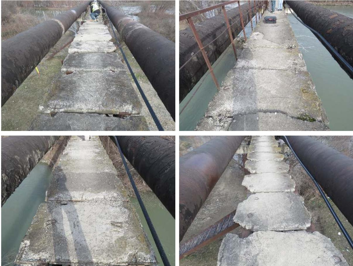
სურ. 12. საგალი ნაწილის რკინაბეტონის ფილის დაზიანებული დამცავი ფენის ბეტონი
